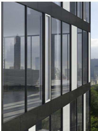
Besonders bei Gebäuden mit moderner Barcode-Architektur erfreuen sich Lüftungsflügel zunehmender Beliebtheit
